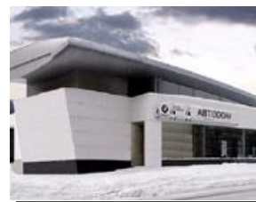
Москва Здание компании "АВТОДОМ"
