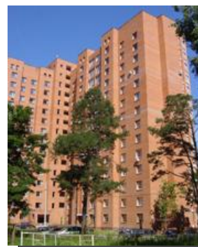
Мытищи Московская область, сеть ИТП
