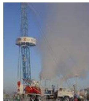
Сургут Автономная котельная на газодобывающей станции.
