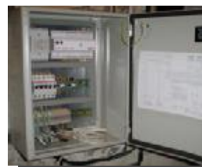
Оренбург Шкаф автоматки
